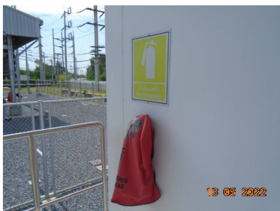
ภาพที่ 2-4 เครื่องดับเพลิงแบบเคมีผง
